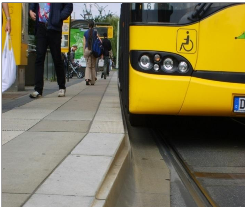
Rys. 8.2 Zalecane ukształtowanie krawędzi peronowej.
