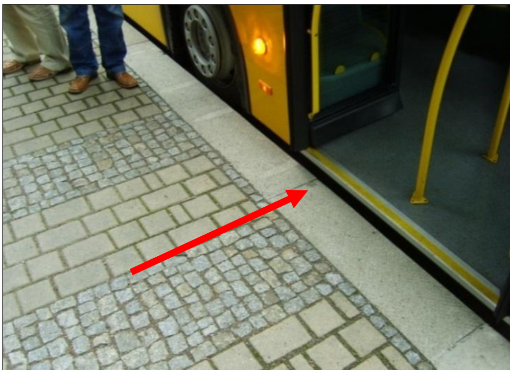
Rys. 8.3 Strefa wejściowa - inny rodzaj nawierzchni naprzeciwko pierwszych drzwi autobusu. Źródło: materiały własne TRAKO.
