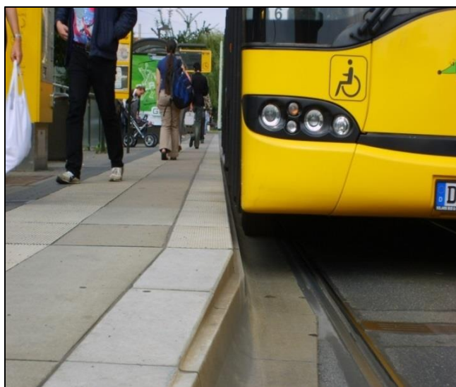
Rys. 8.6.1. Zalecane ukształtowanie krawędzi peronowej.
