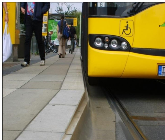
Rys. 8.6.1. Zalecane ukształtowanie krawędzi peronowej.
