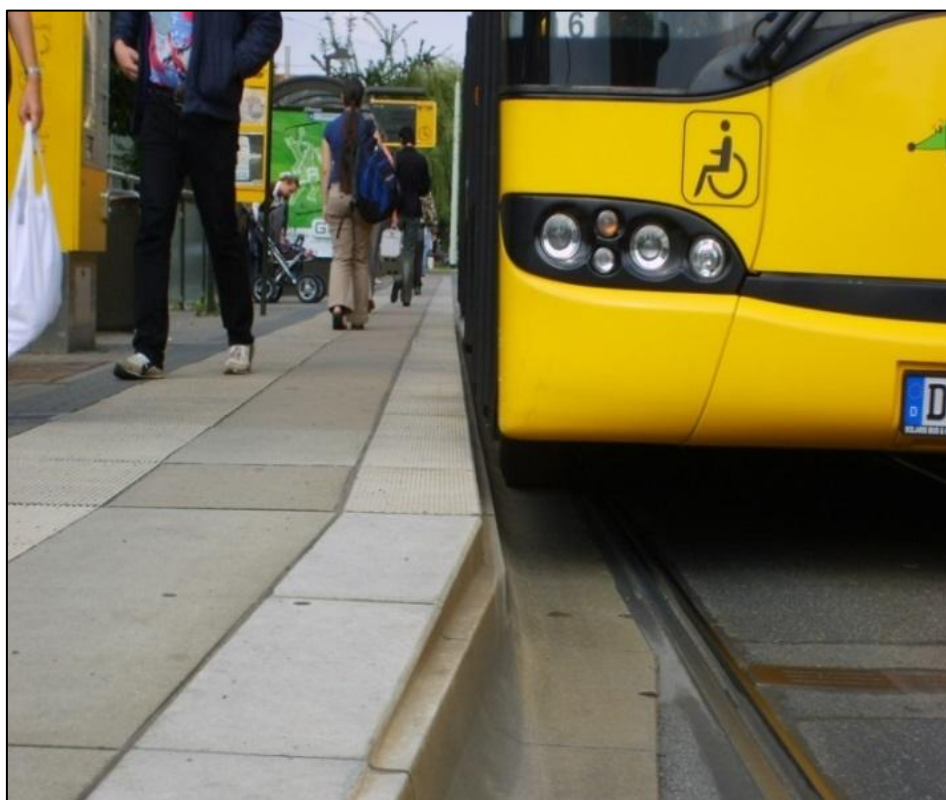
Rys. 8.2 Zalecane ukształtowanie krawędzi peronowej.
