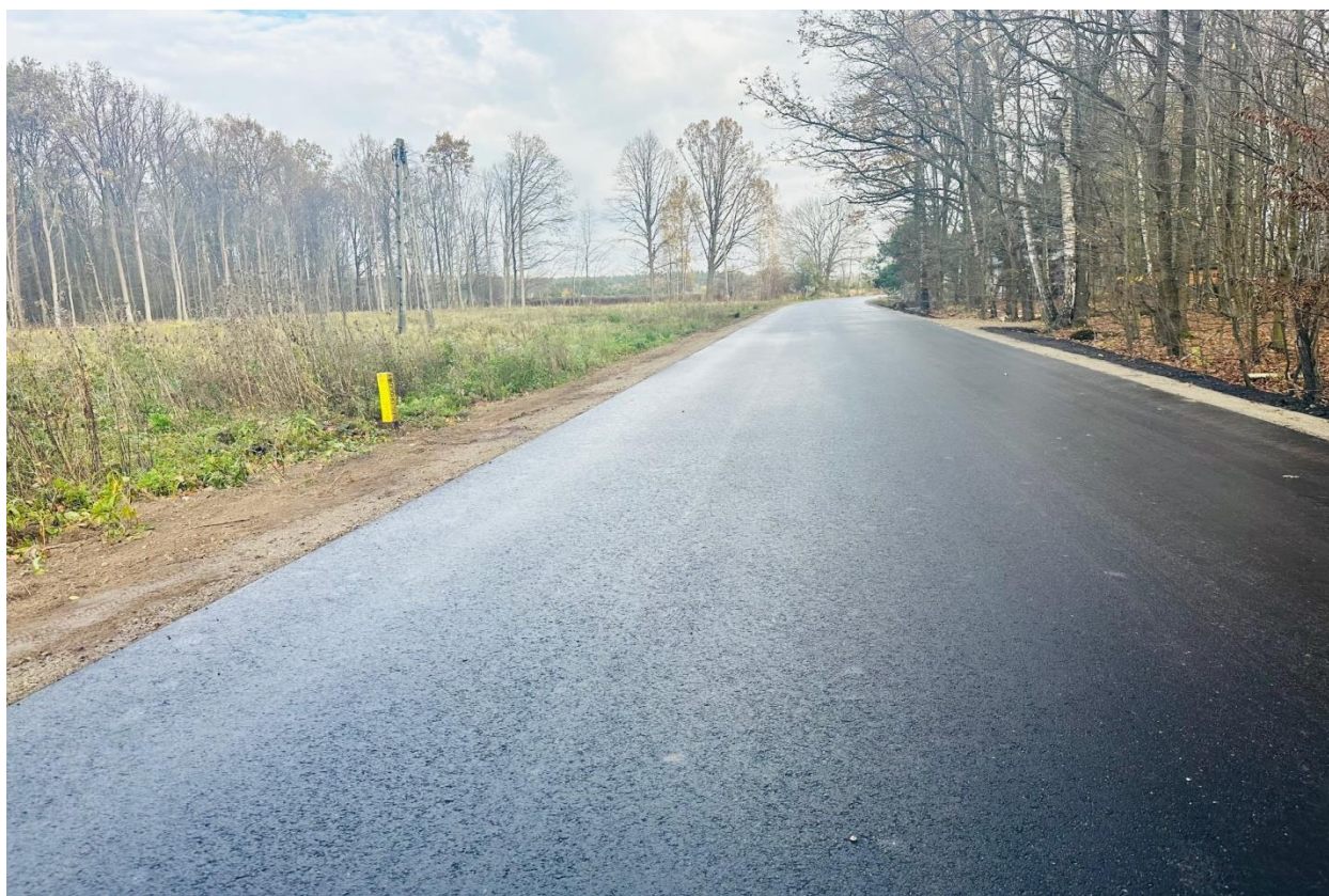
Zdjęcie 8. Rozbudowa drogi powiatowej nr 1550L w miejscowości Majdan Kozłowiecki
