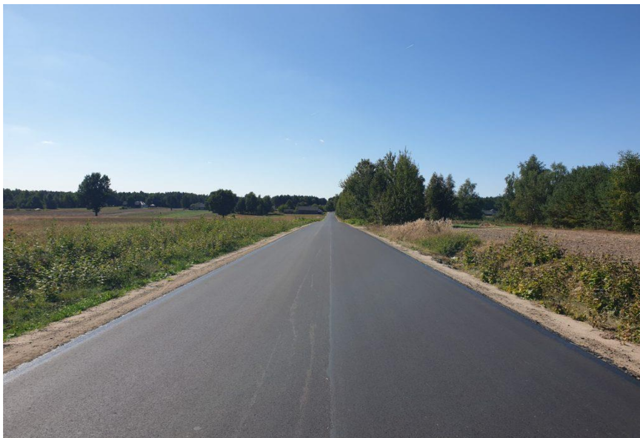
Zdjęcie 7. Remont drogi powiatowej nr 1221L – Tereba Talczyn
