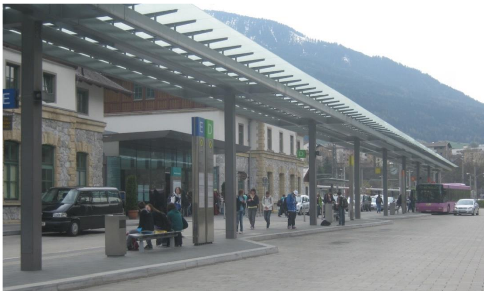
Rys. 12.3.1. Perony autobusowe przed dworcem kolejowym w miejscowości Landeck (Austria). Zaprojektowanie peronów w taki sposób ułatwia ich opuszczenie przez autobus.
