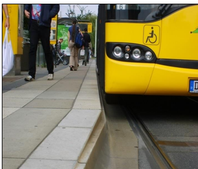
Rys. 8.6.1. Zalecane ukształtowanie krawędzi peronowej.
