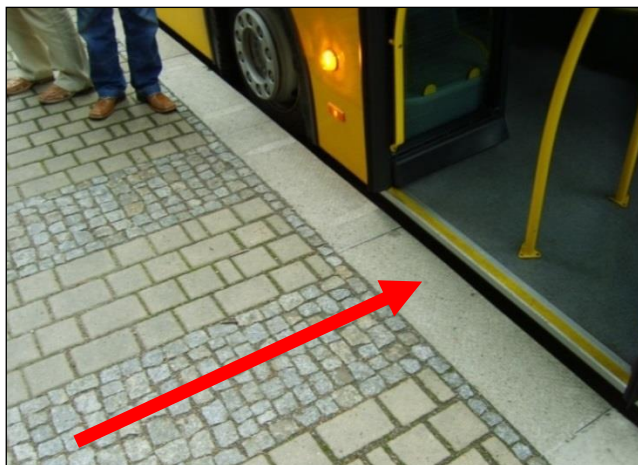
Rys. 8.6.2. Strefa wejściowa – inny rodzaj nawierzchni naprzeciwko pierwszych drzwi autobusu.
